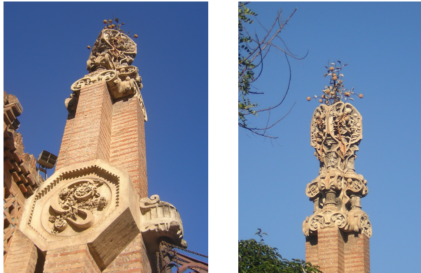
Figura 4: Detalles de pilar con el naranjo y la G inicial de Guëll.
