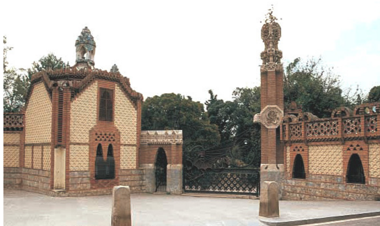
Figura 1: Pabellones de la Finca Güell: Casa del Guardia, puerta y Caballerizas.
